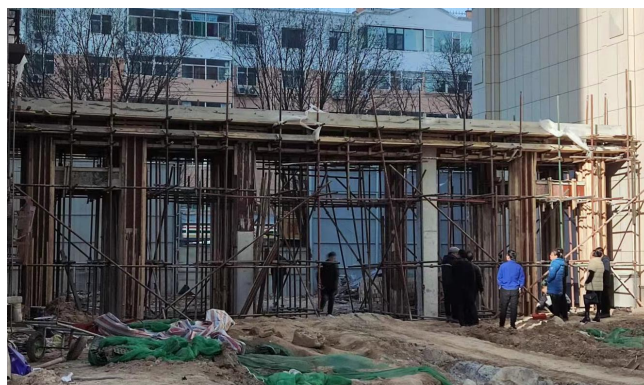
朝阳馨居项目地库、自来水总管安装
