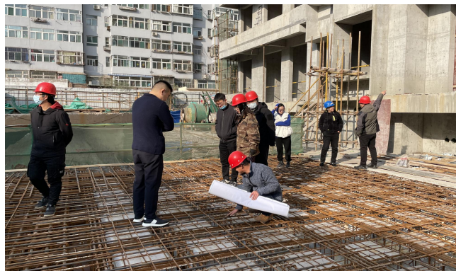
市质监站验收涤纶厂项目地库顶板
