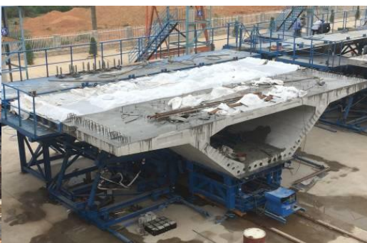
图 3.8-2 短线预制节段箱梁模板
