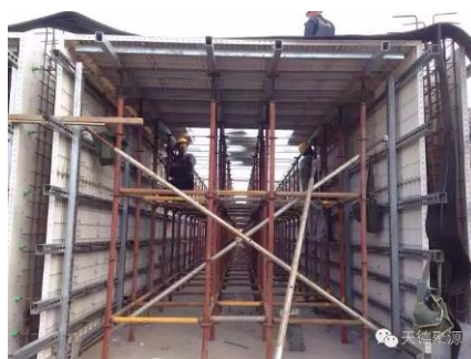
1 混凝土分两次浇筑的模板
