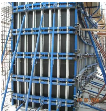
图 3.7-2 清水混凝土模板实例
