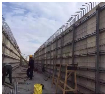
2 混凝土分三次浇筑的模板
