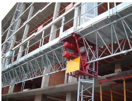
图 3.3 电动桥式脚手架
