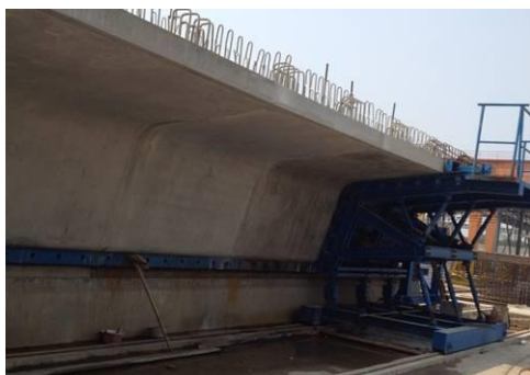
图 3.8-1 长线预制节段箱梁模板
