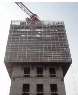
图 3.4-1 液压爬升模板外立面
