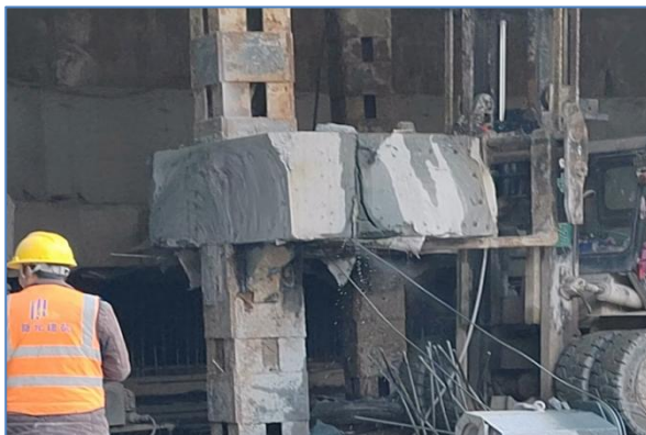
格构柱处混凝土
